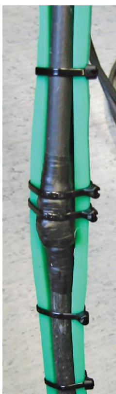
Fot. 1.2.9.4. Jako wzmocnienie połączeń służą plastikowe lubberki, do których wiązadłami są przywiązane końce kabli
